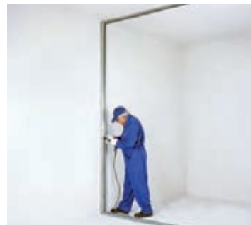
شکل ۱-۵۲- نصب استاد بر روی ساختار جانبی
