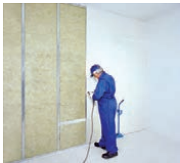
شکل ۱-۶۹- اجرای پانل‌ها در طرف دیگر دیوار
