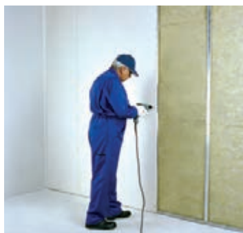
شکل ۸۸-۱- اجرای پانل‌ها در هر طرف دیوار
