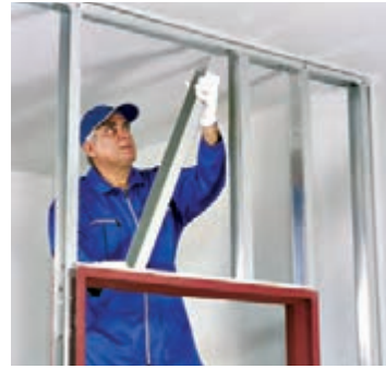
شکل ۱۳۱-۱- استقرار استادهای کتیبه
