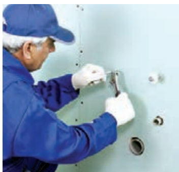
شکل ۱-۱۵۸- اتصال مهرار روشویی به تراورس
