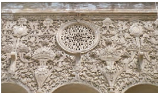
شکل ۲-۲- گچ بری نمای بیرونی
