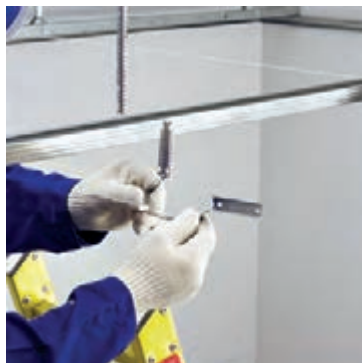
شکل ۳-۵۶- باز کردن رکاب
