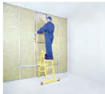
شکل ۱-۶۸- اجرای عایق پشم معدنی در فواصل بین استادها (توجه شود که تأسیسات در مرحله قبل اجرا شده است).
