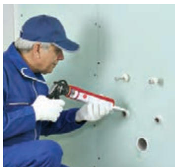
شکل ۱-۱۵۹- اجرای خمیر درزبند در اطراف خروجی‌های تأسیساتی
