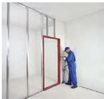
۱-۱۳۸- اجرای پانل اول دور چهارچوب (پانل‌ها به شکل «L» برش داده می‌شوند).
