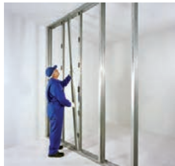
شکل ۸۴-۱- اجرای ردیف دوم استاداها
