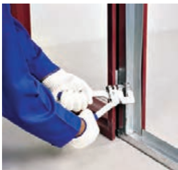
شکل ۱۲۱-۱- اتصال پایین استاد با پانچ
