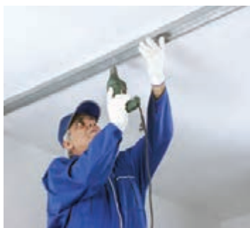
شکل ۴۸-۱- نصب رانر سقف
