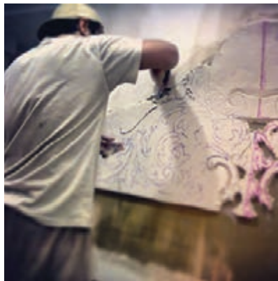
شکل ۳۵-۲- مراحل اجرای گچ‌بری به شیوه درجا
