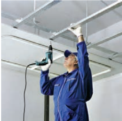
شکل ۳-۶۷ اتصال پانل به زیرسازی توسط پیچ
