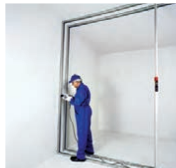
شکل ۹۴-۱- دو ردیف قاب با فاصله از یکدیگر اجرا می‌شود
