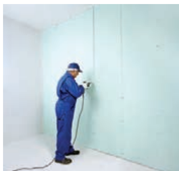
شکل ۱۰۱-۱- اجرای لایه دوم پانل‌ها
