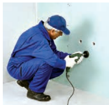
شکل ۱-۱۵۷- ایجاد خروجی‌های تأسیساتی به وسیله گردبر
