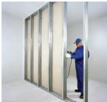
شکل ۸۶-۱- اجرای پانل‌ها در یک طرف دیوار
