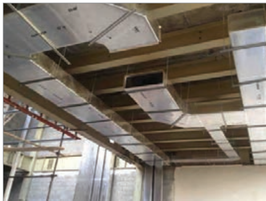
شکل ۱۹-۲- سقف با کانال تأسیساتی
