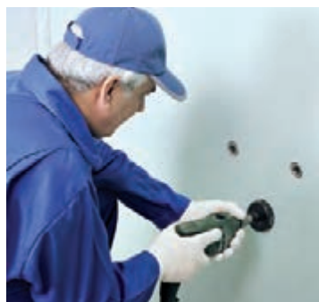
شکل ۱۰۲-۱- ایجاد خروجی تأسیسات به وسیله گرد بر
