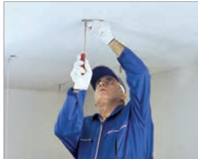
شکل ۳-۱۱۶- اتصال قطعه HT ۹۰ به سقف اصلی شکل ۳-۱۱۷
