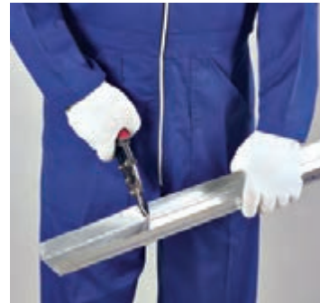
شکل ۱۱۳-۱- برش انتهای رانرهای کف
