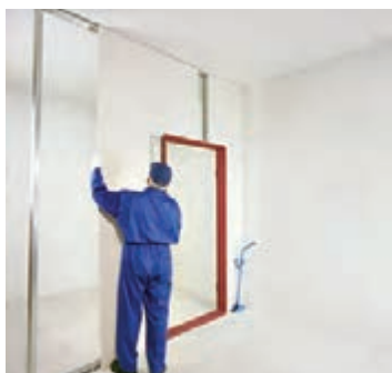
شکل ۱-۱۳۹- اجرای پانل دوم دور چهارچوب
