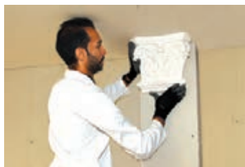
شکل ۲۴۲-۱- اتصال قطعه اول به ستون
