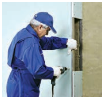
شکل ۱۰۰-۱- اجرای پانل‌ها در طرف دیگر دیوار
