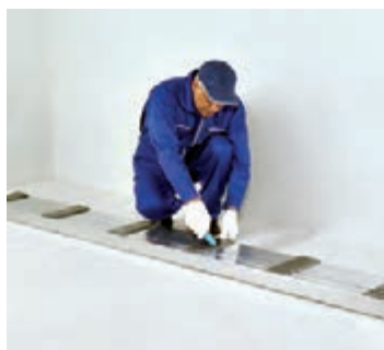
شکل ۸۲-۱- برش نوارهای عایق
