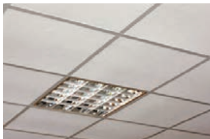
شکل ۳-۴- سقف کاذب مشبک
