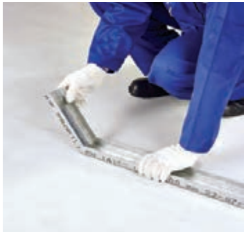
شکل ۱۱۵-۱- خم کردن انتهای رانر کف
