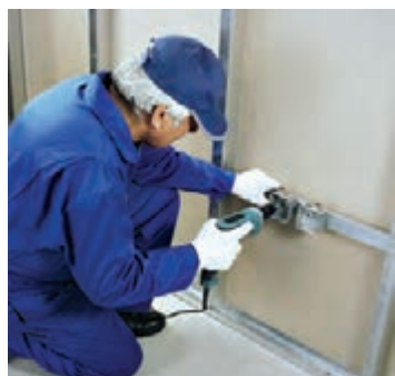
شکل ۱-۱۶۹- اتصال قوطی برق به سازه پشتیبان
