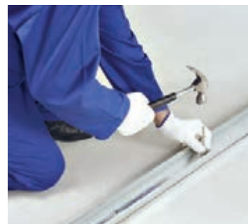
شکل ۴۲-۱- اتصال رانر به کف با رول پلاک
