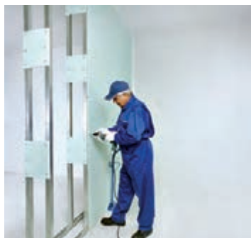
شکل ۹۸-۱- اجرای پانل‌ها در یک طرف دیوار
