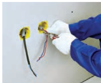
شکل ۱۷۶- گیره‌ها توسط پیچ گوشتی جمع می‌شوند.
