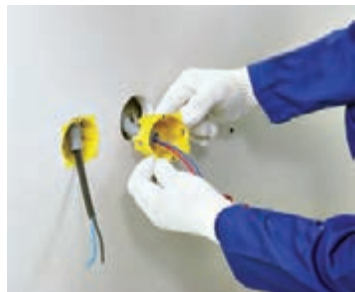
شکل ۱۷۵- در حالی که گیره‌ها باز هستند، قوطی برق در محل خود قرار می‌گیرد.
