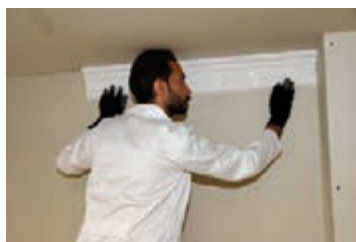
شکل ۲۴۵-۱- نصب قطعه پلی یورتان با چسب
