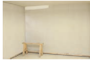
شکل ۲۳۴-۱- اجرای بتونه (زیر سازی)
