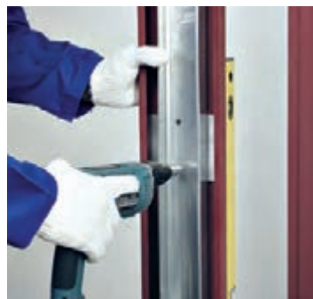
شکل ۱۲۵-۱- چهارچوب توسط پیچ LB در محل صفحات به استادها متصل می‌شود. شکل ۱۲۶-۱- علامت‌گذاری انتهای رانر نعل درگاه به صورت فارسی بر ( به اندازه ۲۰ سانتی‌متر) شکل ۱۲۷-۱- برش انتهای رانر نعل درگاه
