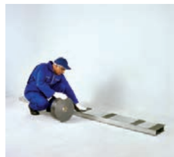
شکل ۸۱-۱- اجرای نوار عایق بر روی استاداها
