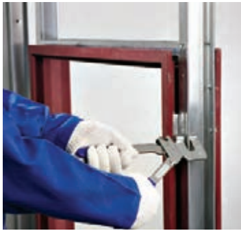
شکل ۱۳۰-۱- اتصال رانر نعل درگاه به استادهای پانچ
