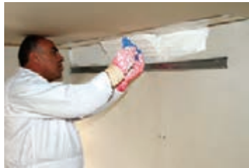
شکل ۲۳۸-۱- کشیدن ابزار
