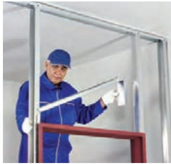
شکل ۱۲۹-۱- استقرار رانر نعل درگاه
