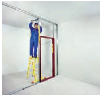
شکل ۱۲۲-۱- اتصال بالای استاد با پیچ LB شکل ۱۲۳-۱- اتصال چهارچوب به استاد شکل ۱۲۴-۱- اتصال چهارچوب به استاد اول دوم
