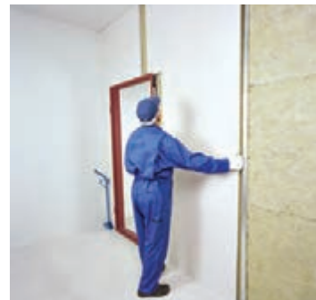
شکل ۱۴۳-۱- اجرای پانل چهارم دور چهارچوب
