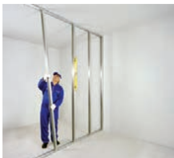
شکل ۸۳-۱- اجرای ردیف اول استاداها (به صورت شاقولی)
