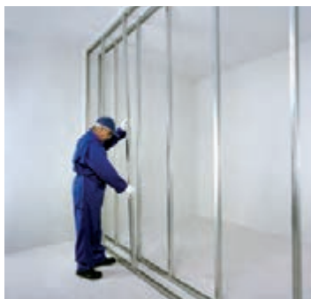
شکل ۹۶-۱- شاقولی کردن ردیف اول استادها
