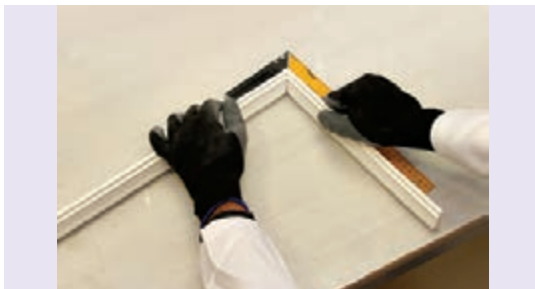
شکل ۲۲۹-۱- کنترل گونیا بودن قطعات قبل از نصب
