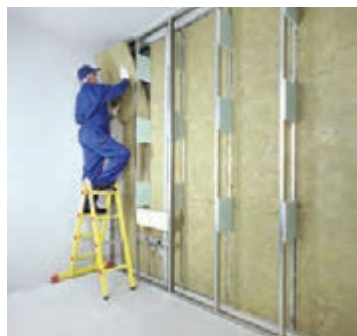
شکل ۹۹-۱- اجرای عایق معدنی
