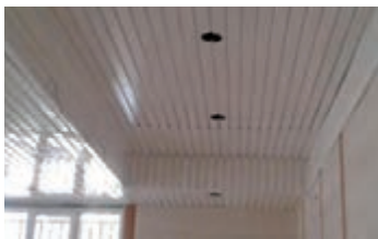
شکل ۳-۳- سقف کاذب فلزی
