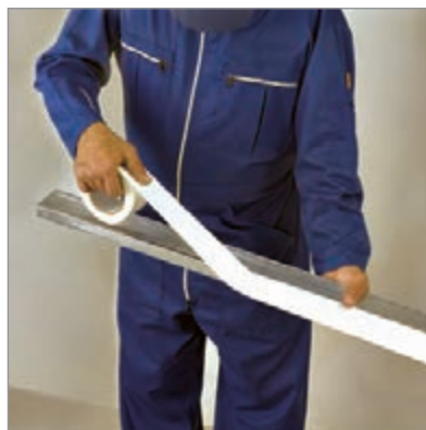
شکل ۸۵-۳- چسباندن نوار ترن فیکس بر روی سازه
