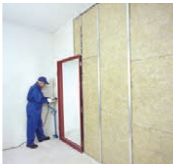
شکل ۱-۱۴۲- پیچ زنی پانل در حاشیه دور چهارچوب
