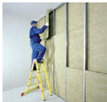
شکل ۸۷-۱- اجرای عایق پشم معدنی
