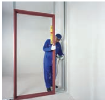
شکل ۱۲۲-۱- اتصال بالای استاد با پیچ LB شکل ۱۲۳-۱- اتصال چهارچوب به استاد شکل ۱۲۴-۱- اتصال چهارچوب به استاد اول دوم
