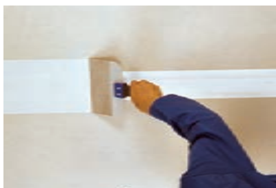
شکل ۳-۸۲- قرار دادن نوار درزگیر بر روی بتونه
