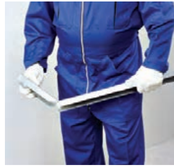
شکل ۱۲۸-۱- خم کردن انتهای رانر نعل درگاه
