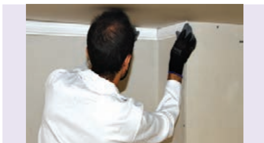
شکل ۲۳۲-۱- نصب قطعه نهایی
