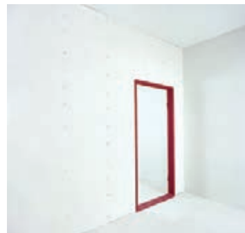
شکل ۱-۱۴۰- پانل‌گذاری در یک سمت دیوار تکمیل شده
