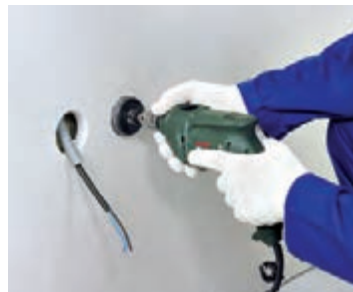
شکل ۱۷۳- خروجی‌های تأسیساتی به وسیله گردبر ایجاد می‌شوند.
