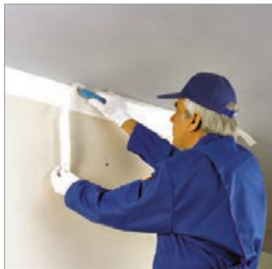
شکل ۳-۸۸- برش اضافات نوار چسب جداکننده پس از خشک شدن بتونه
