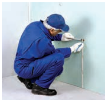
شکل ۱-۱۵۶- تعیین محل خروجی‌های تأسیساتی
