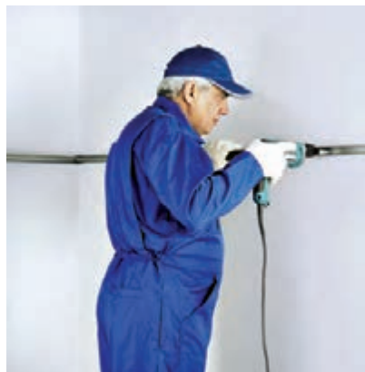
شکل ۳-۴۵- نصب سازه تراز
