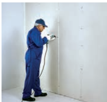
شکل ۸۹-۱- اجرای لایه دوم پانل‌ها
