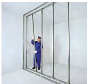
شکل ۹۵-۱- اجرای ردیف اول استادها
