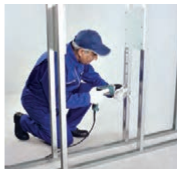
شکل ۱-۱۵۴- اتصال قطعات نبشی L۲۵ به استاد‌های مجاور
