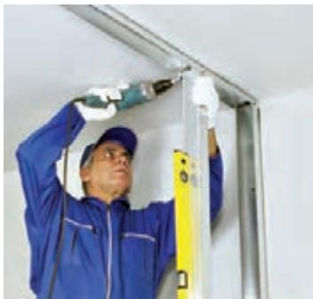
شکل ۱۱۸-۱- اتصال بالای استاد با پیچ LB
