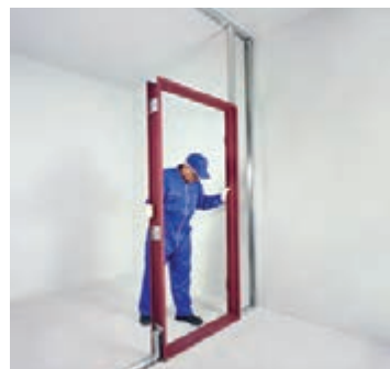
شکل ۱۱۹-۱- استقرار چهارچوب در
